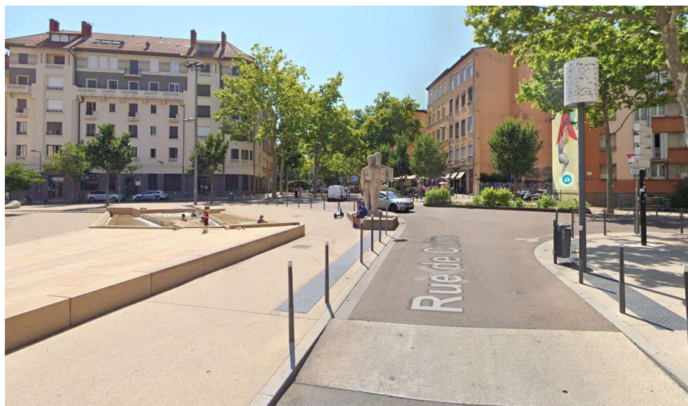
Un plateau traversant tout autour de la place pour réduire la vitesse et sécuriser la traversée pour les piétons. Lyon, place des Tapis - 2022
