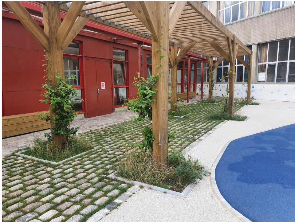
École élémentaire Emile Levassor_pergola végétalisée - © CAUE Paris
